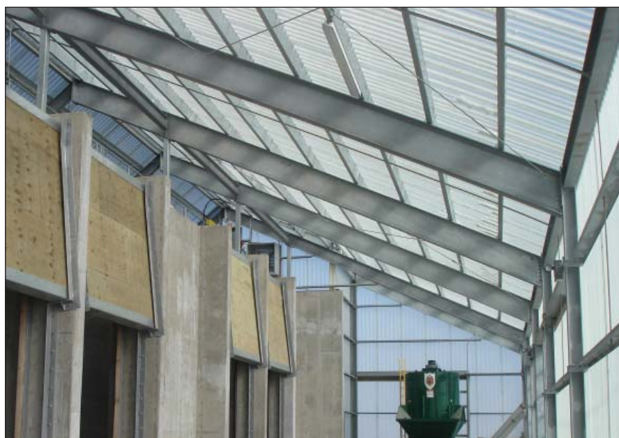
Instalación para almacenaje de fertilizantes con tejado y paneles laterales DuroLite de Enduro
